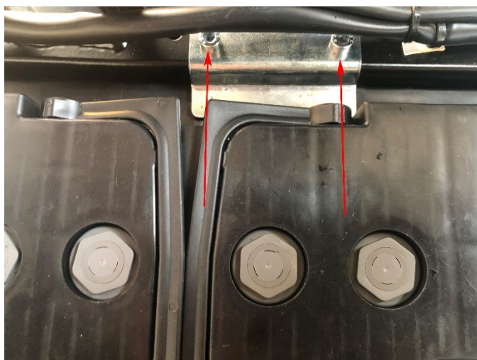
Figure 6 Remplacement des batteries
